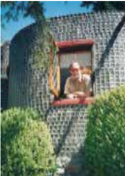
Construcciones con botellas
