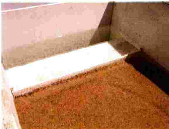
Filtro dinámico para Kwakukundala
