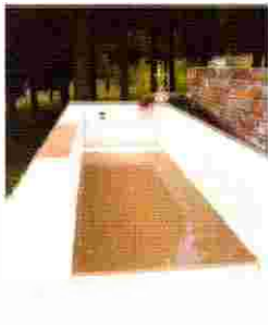
Filtro dinámico para Kwakukundala
